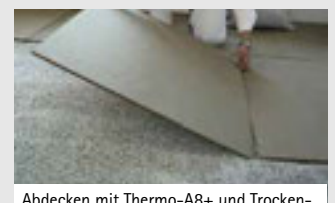
Abdecken mit Thermo-A8+ und Trockenestrich wie Thermo GE
