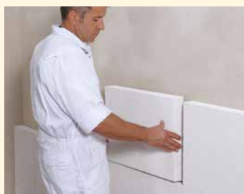
3. An Wand oder Decke einschwimmen und andrücken – fertig!
